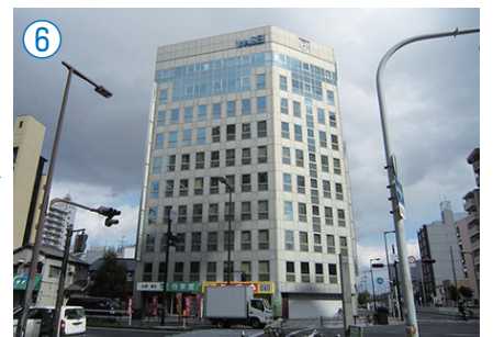
⑥ 日大和生ビル
